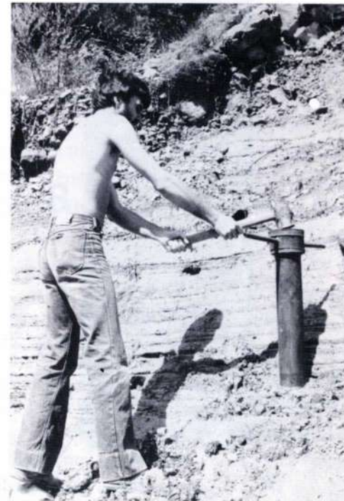
Fig. 4 - Carotatura. - Coring.
