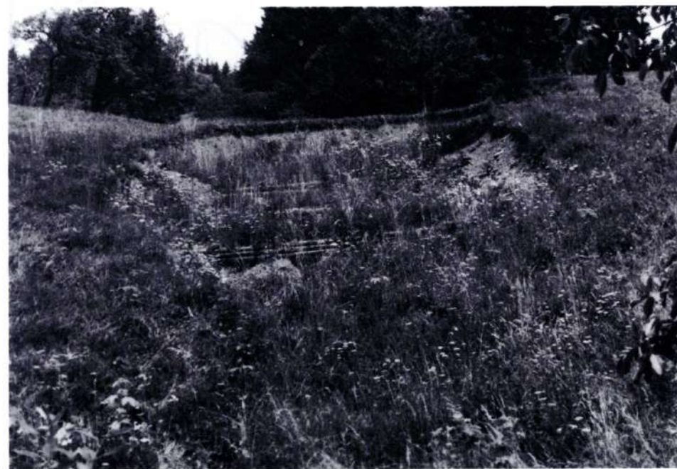
Fig. 3 - Dissesto in corso di ripascimento tramite fascinate. Si nota in corona ancora un elevato grado di dissesto. - Landslide in accretion with fascines. In the crown the failure is still marked.
